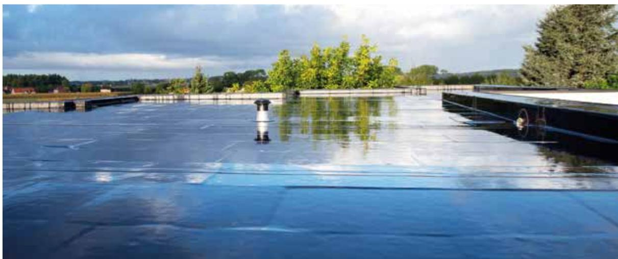
**Le caoutchouc EPDM** - acronyme de Ethylène-Propylène-Diène Monomère - est un élastomère spécifique obtenu par vulcanisation, à la structure moléculaire très stable, commercialisé au début des années 60.
